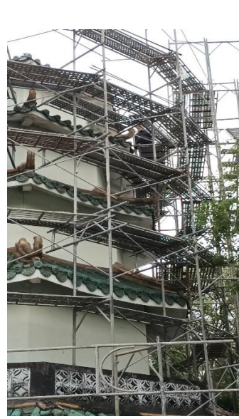
祖塔外部修繕中照片 2
