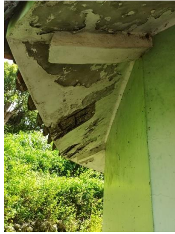
祖塔外部修繕前照片 2
