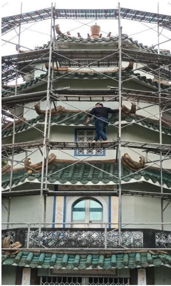
祖塔外部修繕中照片 1
