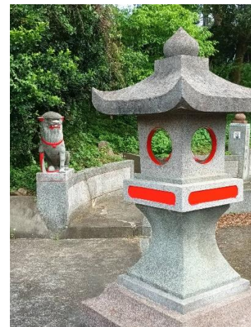
祖塔外部修繕後照片 3
