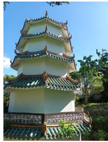
祖塔外部修繕前照片 3
