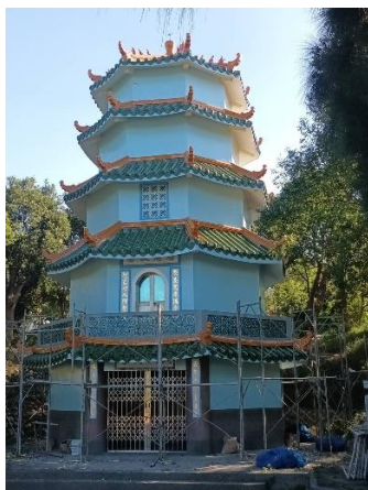
祖塔外部修繕後照片 1
