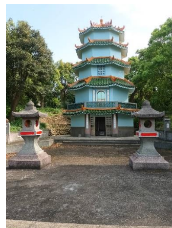
祖塔外部修繕後照片 2
