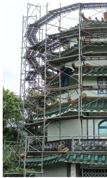
祖塔外部修繕中照片 3
