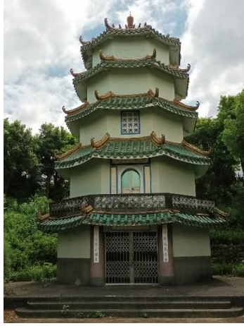
祖塔外部修繕前照片 1
